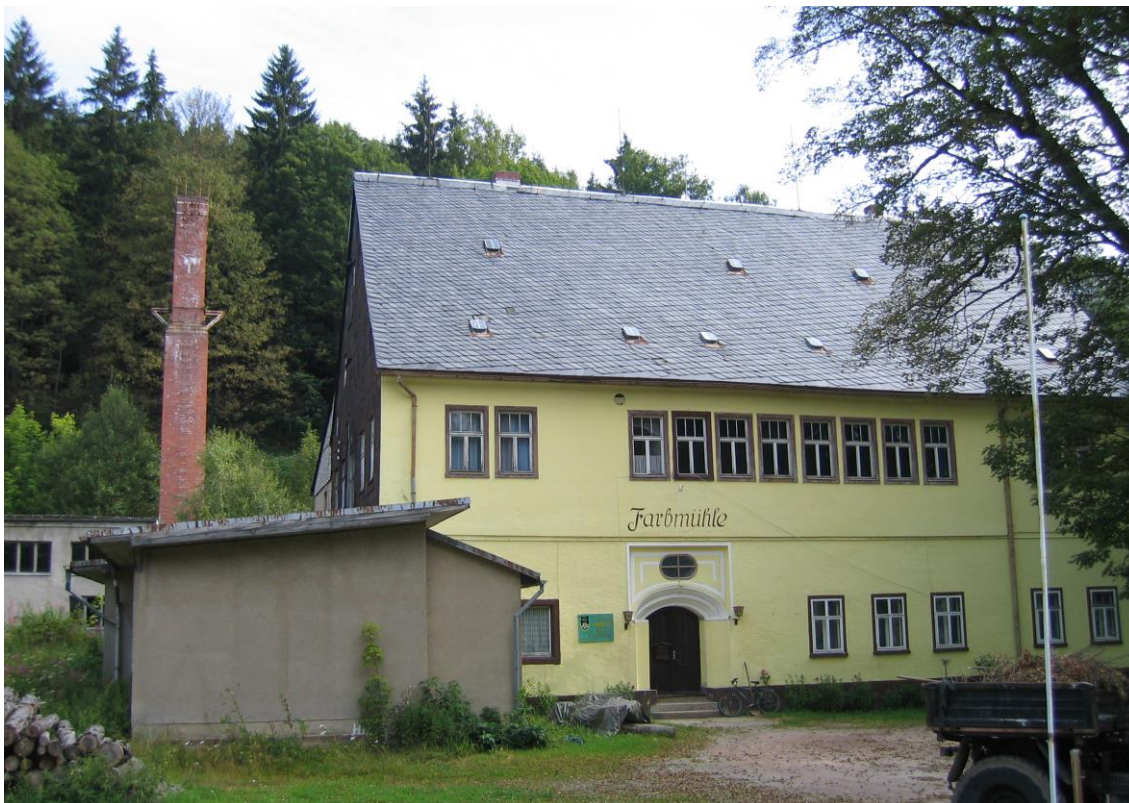
Fig. 8.18 - Vecchia casa padronale della Blaifarbenwerk ( Farbmühle ) di [Unter]Jugel vicino Johanne-orgenstadt, successivamente trasformata in Gasthaus.
