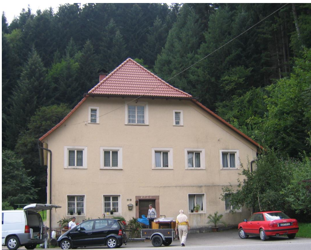
Fig. 8.22 - Residenza padronale della Blaifarbenwerk di Wittichen (Schenkenzell), edificata nel 1722.
