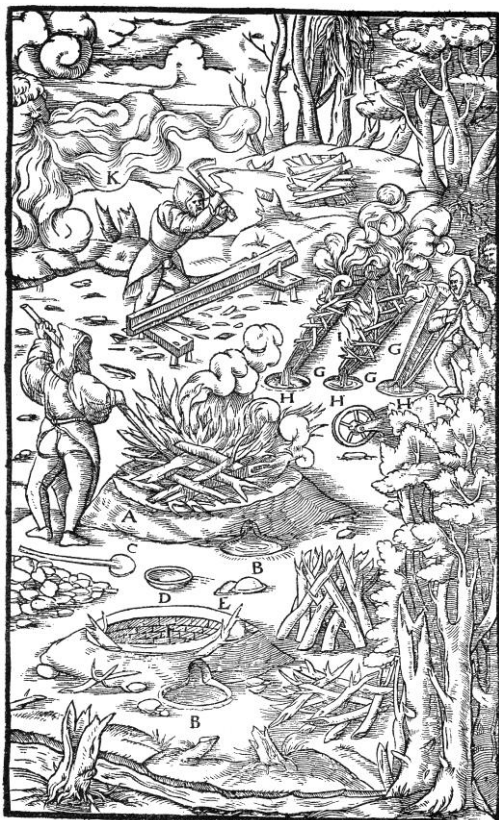
Fig. 1.9 - Arrostimento dei minerali di bismuto, dal De re metallica di Georgius Agricola. AGRICOLA 1556 e 1561, p. 350.
