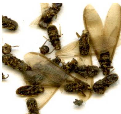
Fig. 3.8 - Resti di termiti ritrovati nel corso di una ispezione in un locale di deposito archivistico
