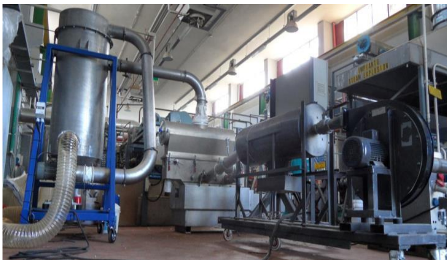
Figura 16: Realizzazione del sistema di detossificazione presso l'impianto ENEA.
