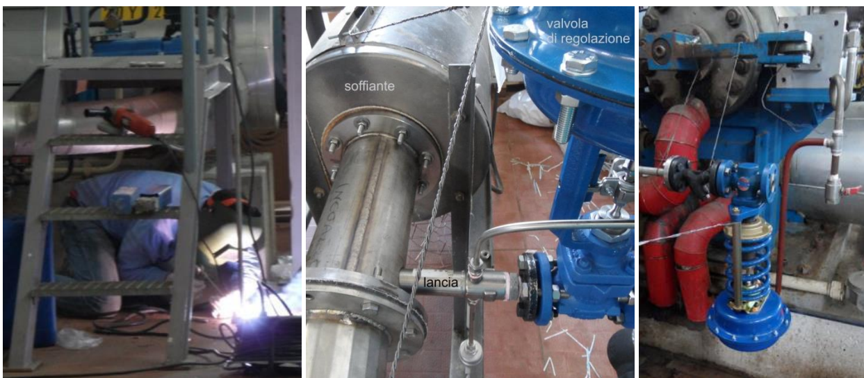
Figura 25: Fasi della realizzazione della linea vapore.
