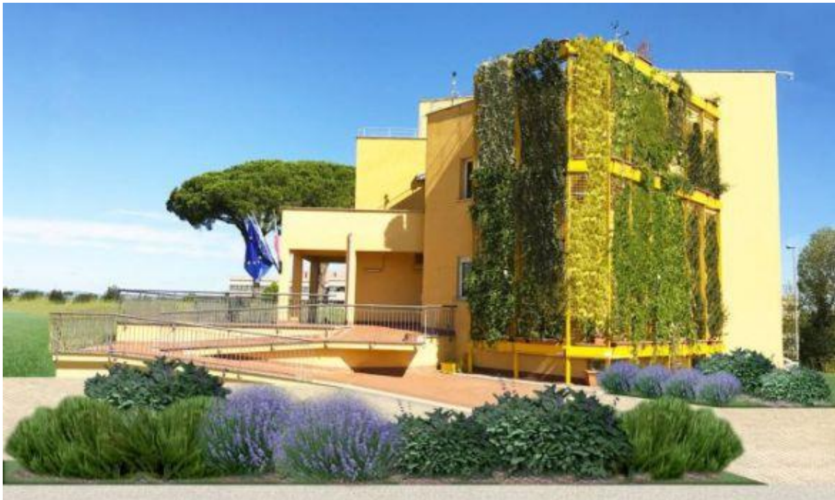
Figura 7 - Edificio Prototipo sperimentale ENEA di pareti e tetto verde
