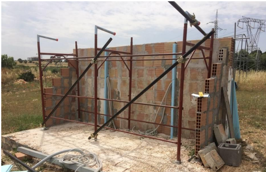
Figura 9 - Prototipo presso il campo sperimentale dell'Università di Bari: struttura portante metallica interna, parete rivolta a sud e rinforzi laterali, separazione delle sezioni realizzata con pannelli termoisolanti in polistirene espanso (in azzurro).
