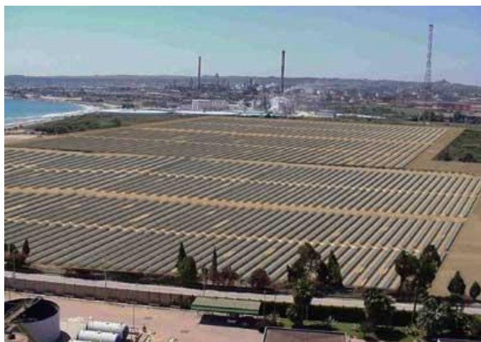
Figura 2-10 – Ricostruzione fotografica dell'impianto Archimede
