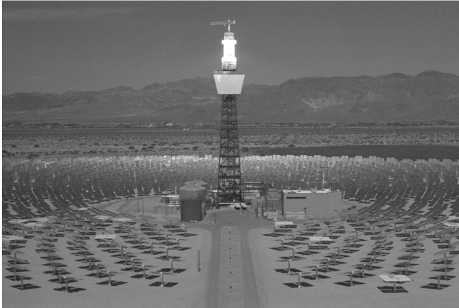
Figura 2.3 – Impianto Solar Two presso Daggett, California
