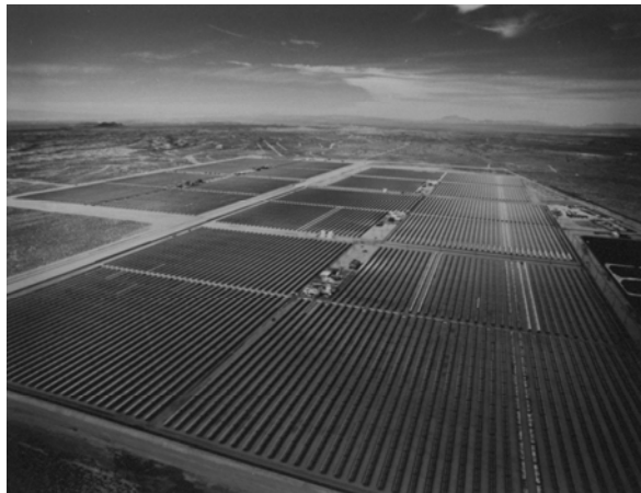
Figura 2.5 – Impianto a collettori parabolici lineari presso Kramer Junction, California
