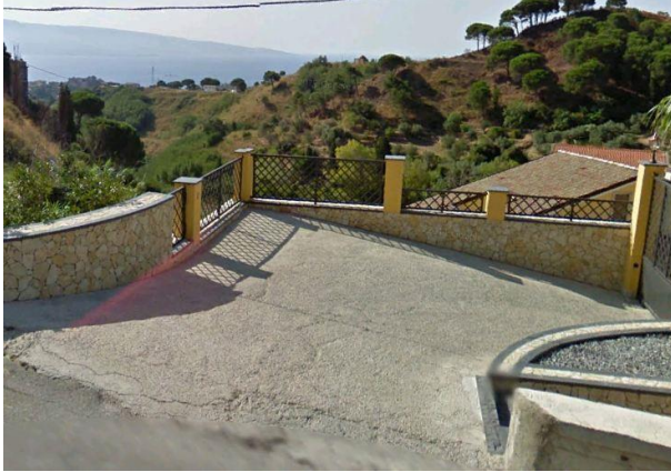
Figura 45- Angolo della piazzola. Foto senza antenna GPS.
