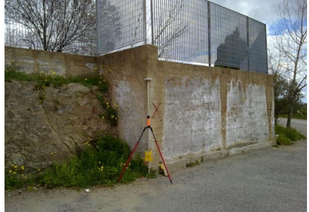
Figura 51 - Angolo del muro di recinzione.
