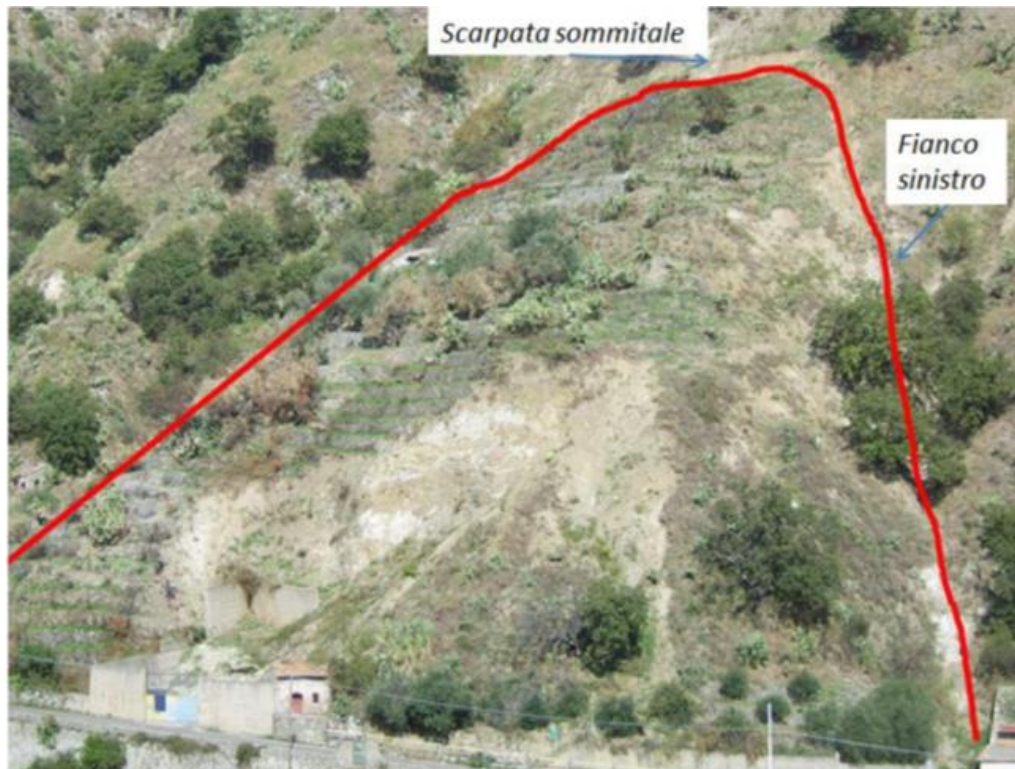
Figura 27 - Scorrimento traslazionale incombente sulla S.P. 38 (Mili San Pietro); in evidenza gli elementi morfologici principali
