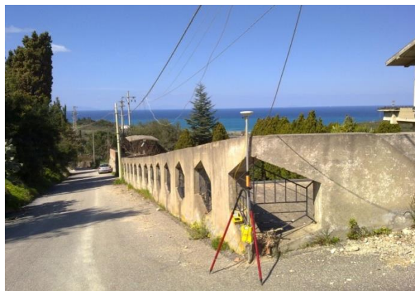
Figura 40 - Angolo del muretto di recinzione.
