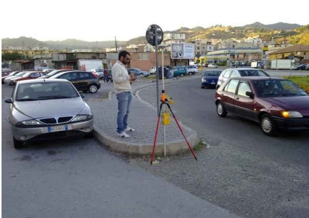
Figura 5 - Fine del marciapiede.
