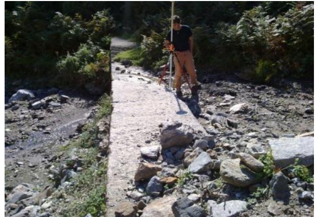
Figura 18 - Cambio di pendenza sulla briglia.
