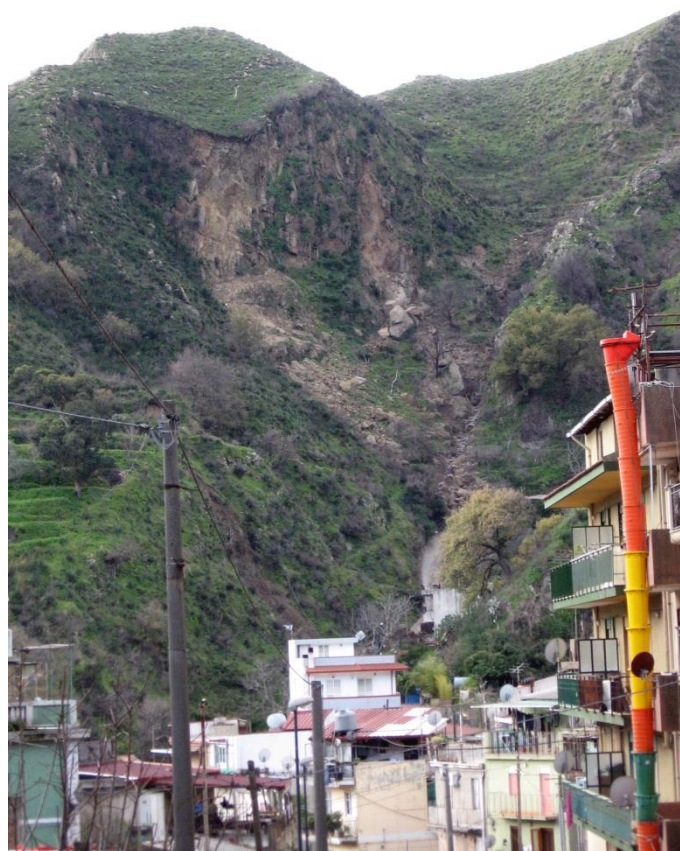
Figura 3 – Crollo in unità metamorfiche al di sopra di edifici dell’abitato di Mili S. Pietro
