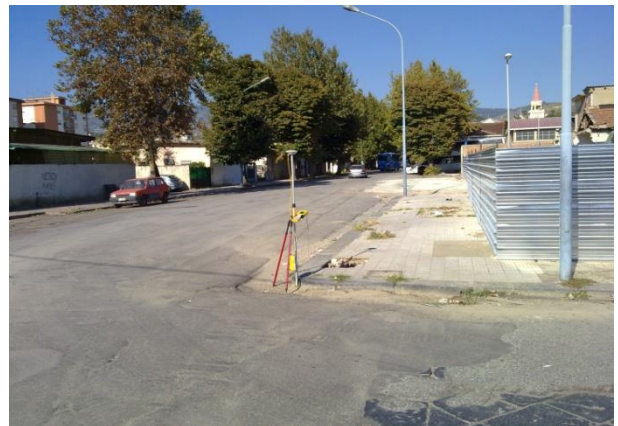
Figura 6 - Angolo del marciapiede.
