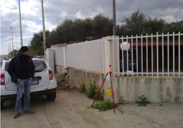
Figura 51 - Angolo del muretto di recinzione.
