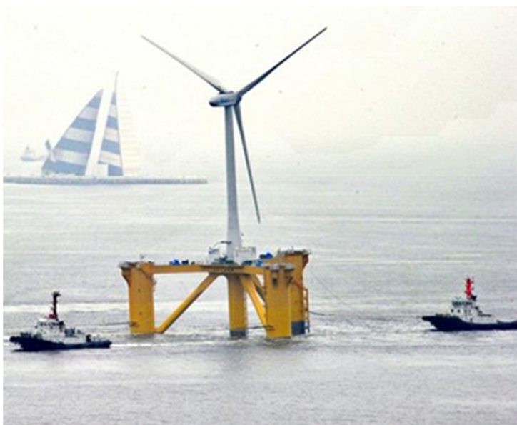
Fig. 24 - Prototipo di turbina galleggiante giapponese esce dal porto; non è particolarmente accattivante, ma sarà posizionata a grande distanza dalla costa.
