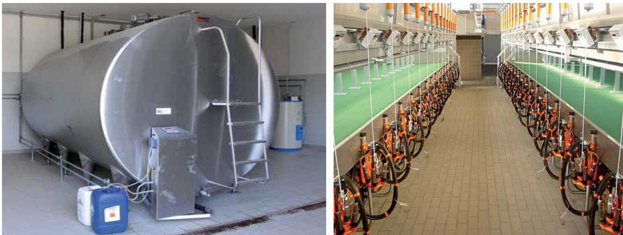
Serbatoio (tank) di raccolta e di refrigerazione del latte (sinistra). Sala di mungitura a pettine (destra). (Fonte: CRPA)
