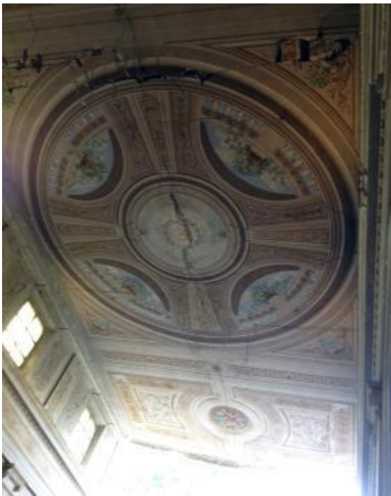
Fig. 4 La copertura della navata centrale
