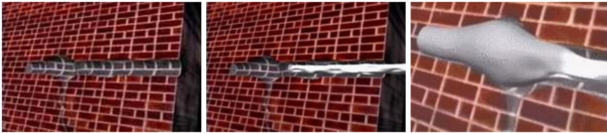
Realizzazione del foro
