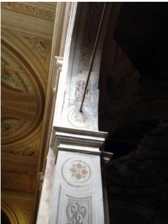
Fig. 13 Traslazione pilastro della navata destra
