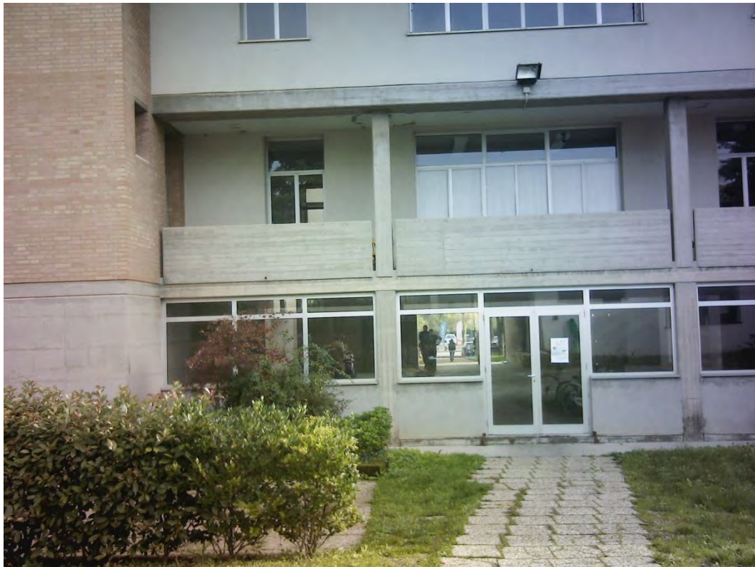
Fig. 57 – Dettaglio facciata principale
