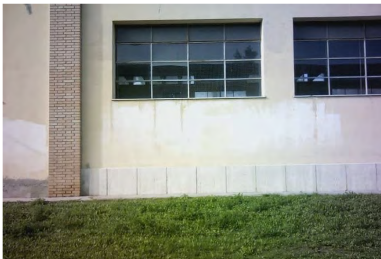
Fig. 27 – Risarcitura muro esterno
