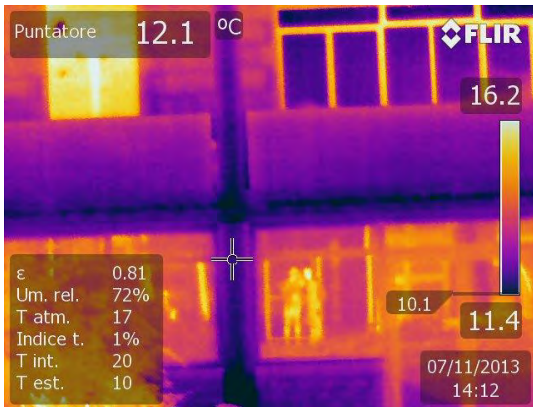
Fig. 58 – Termografia porzione facciata principale
