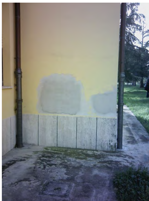
Fig. 74 – Piccoli interventi in facciata
