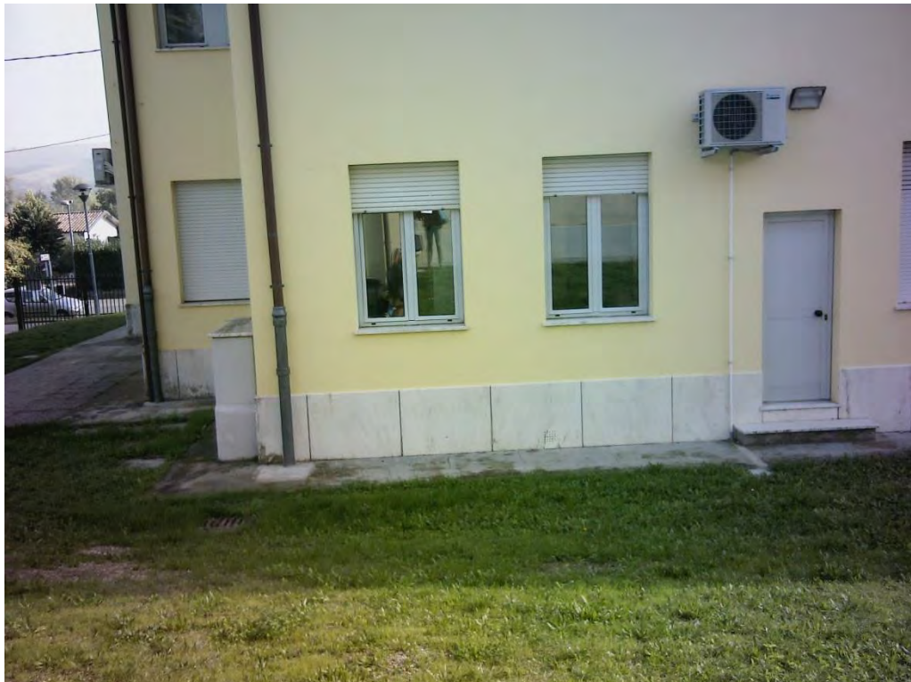
Fig. 71 – Porzione di facciata
