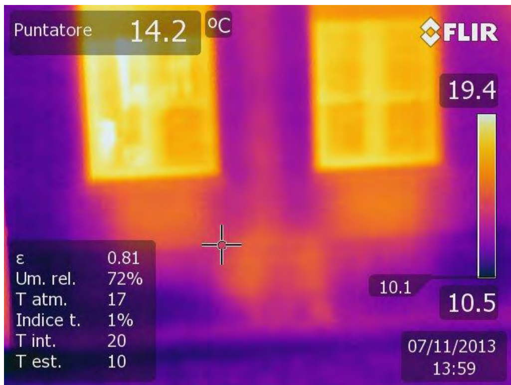
Fig. 72 – termografia porzione di facciata
