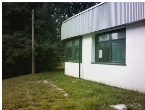
Fig. 21 – Muro esterno biblioteca
