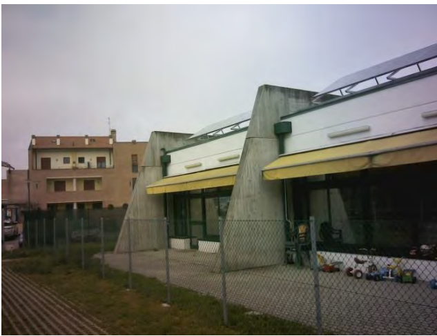
Fig. 36 – Struttura in c.a.
