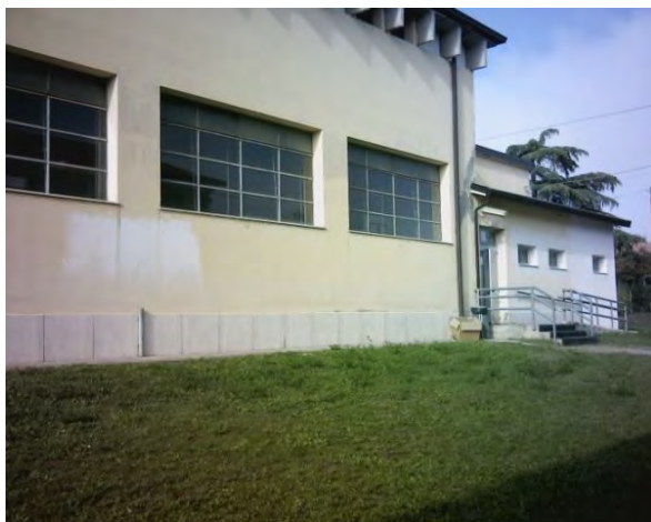
Fig. 26 – Dettaglio muro esterno Palestra
