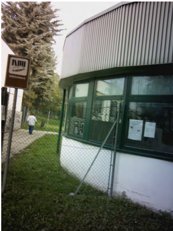
Fig. 16 – Particolare muro esterno
