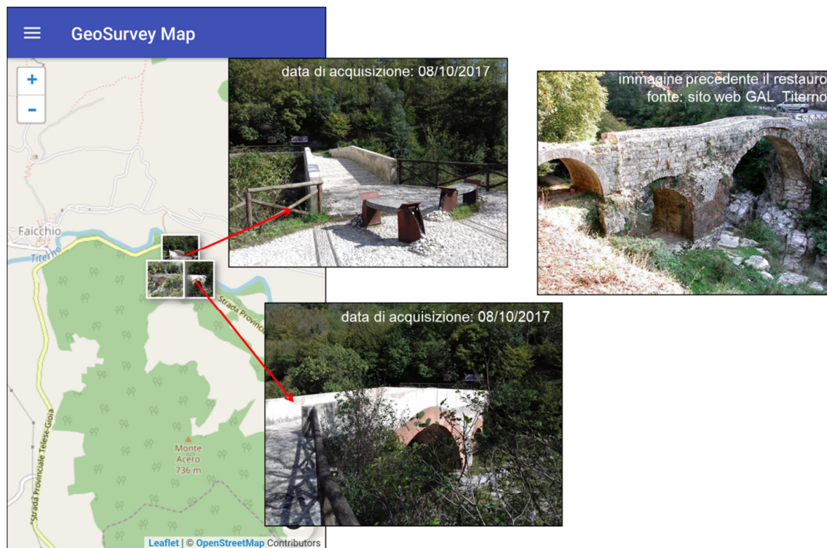
Figura 15. Confronto tra lo stato di un ponte di età romana prima e dopo un intervento di restauro
