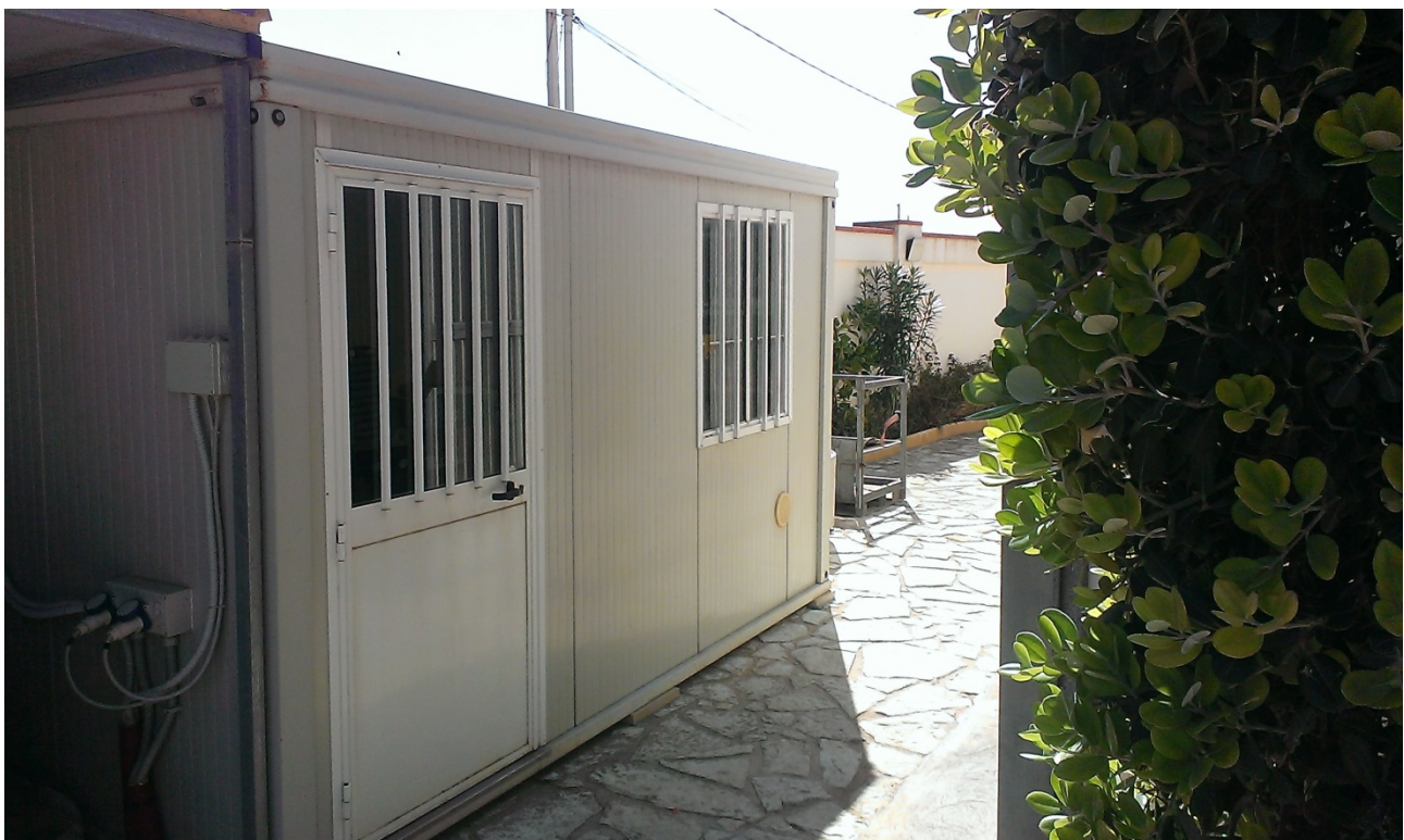
Figura 7. Modulo prefabbricato installato a Capo Granitola.
