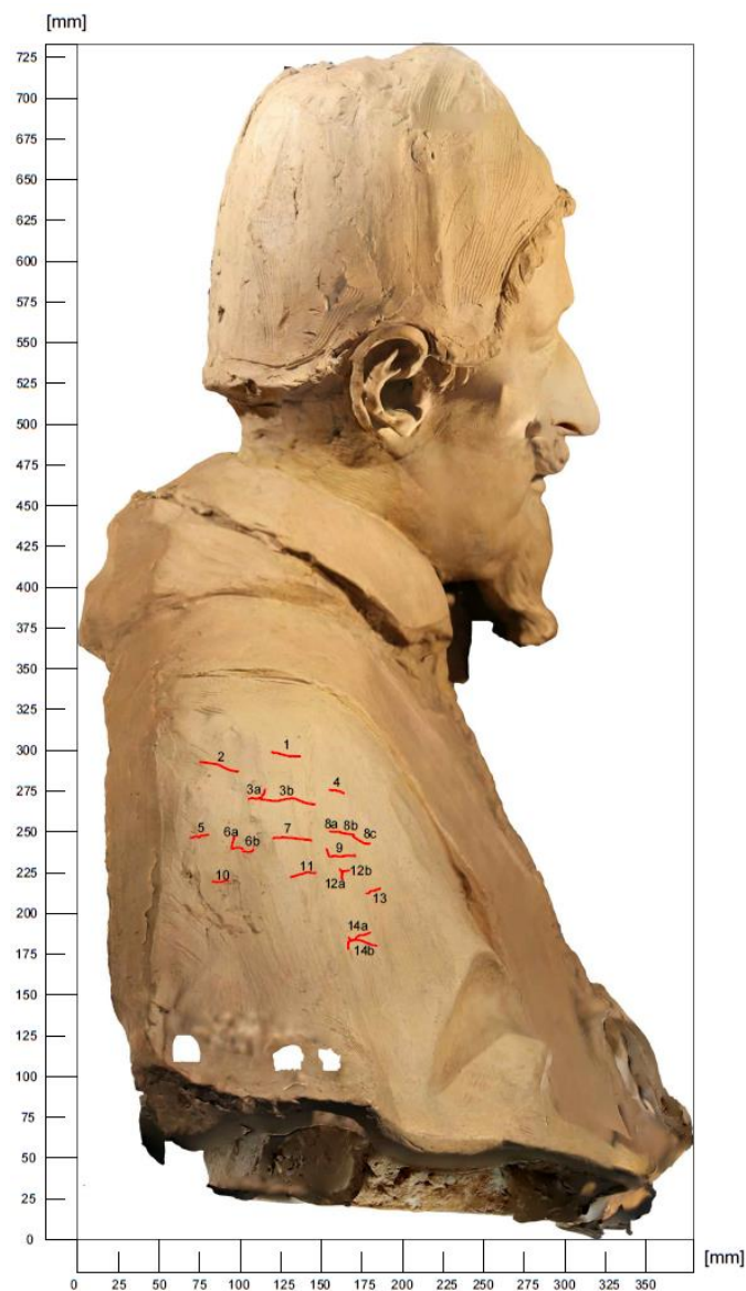
Figura 19: Ricostruzione fessure spalla destra
