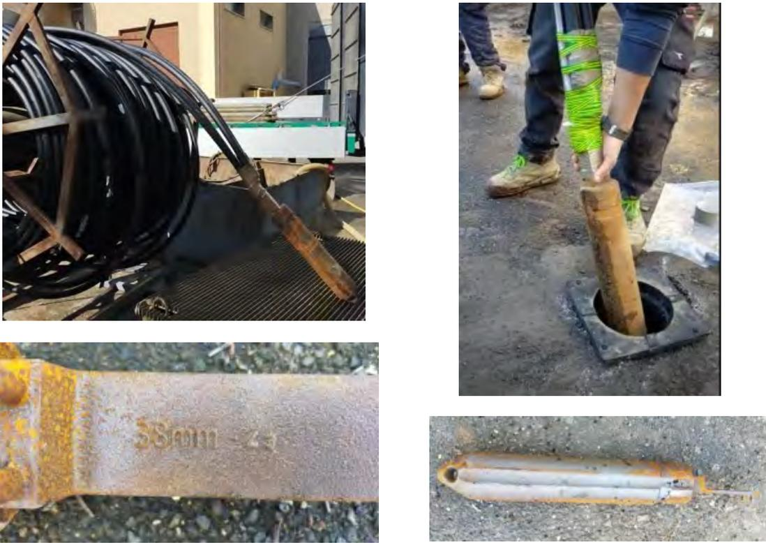
**Figura 10:** In senso orario: peso zavorrato fissato al piede della sonda geotermica; inserimento nel pozzo; zavorra, con l'indicazione del diametro (38 mm) e del peso (43 kg)
