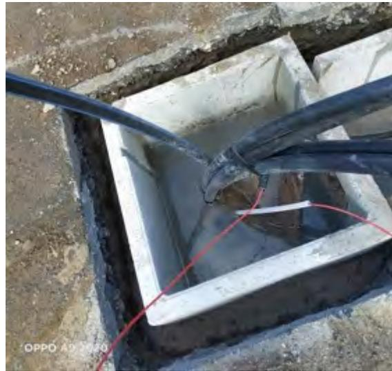
**Figura 12:** Cementazione del foro con malta cementizia. Il tubicino bianco, di minor diametro, che si vede in entrambe le foto, contiene la fibra ottica. Il tubo isolato dagli altri, che nella foto a sinistra è tenuto dall'operatore, è il tubo getto
