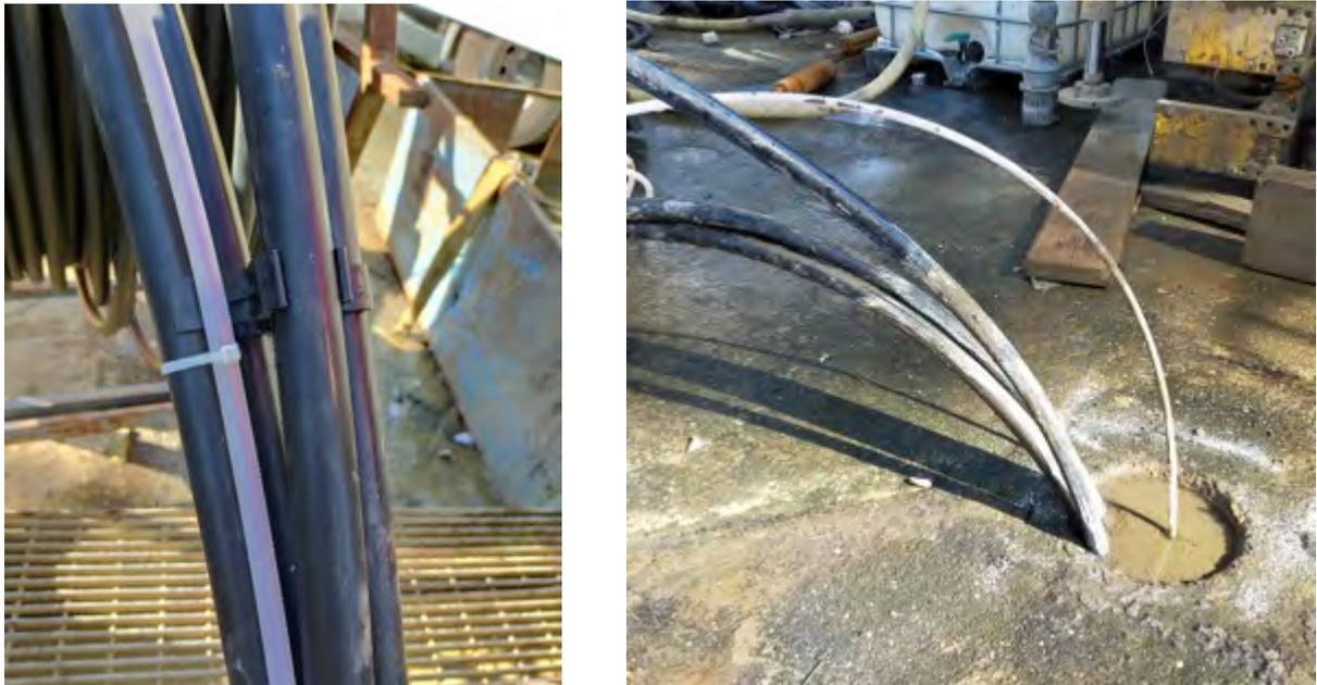
**Figura 28:** Assemblaggio del tubicino contenente la fibra ottica alle sonde geotermiche
