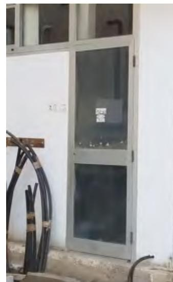
**Figura 13:** In senso orario: vista dall'alto del campo geosonde; trincee orizzontali, contenenti le sonde geotermiche e i corrugati a protezione delle fibre ottiche; locale sala controllo: sulla sinistra arrivo delle sonde geotermiche, sulla destra della porta si vede il punto di ingresso dei corrugati; particolare dei quattro fasci di tubazioni provenienti dai pozzi
