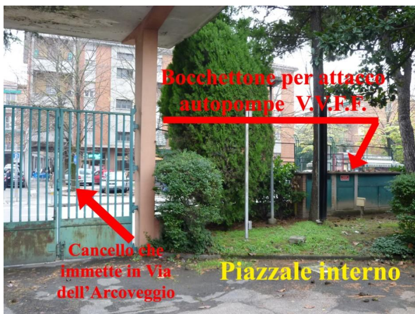
Figura 7.1 – Posizione armadio attacco autopompa Vigili del fuoco
