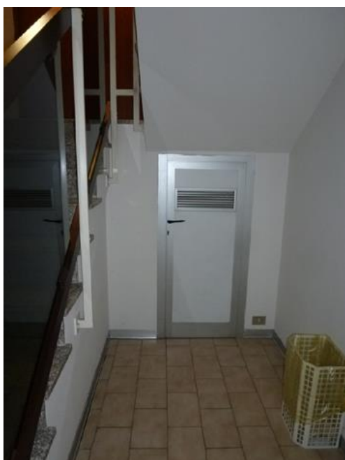
Figura 5.17 – Locale valvole acqua palazzina E palazzina E
