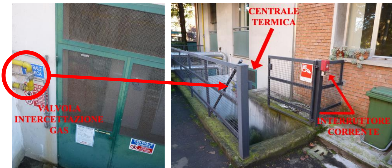
Figure 2.10 e 2.11 – Ingresso centrale termica capannone F-D
