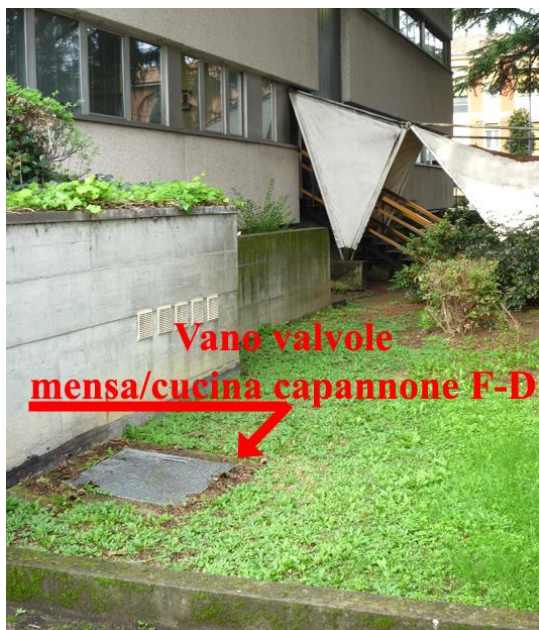
Figura 5.18 - Il vano valvole acqua mensa/cucina capannone F-D
