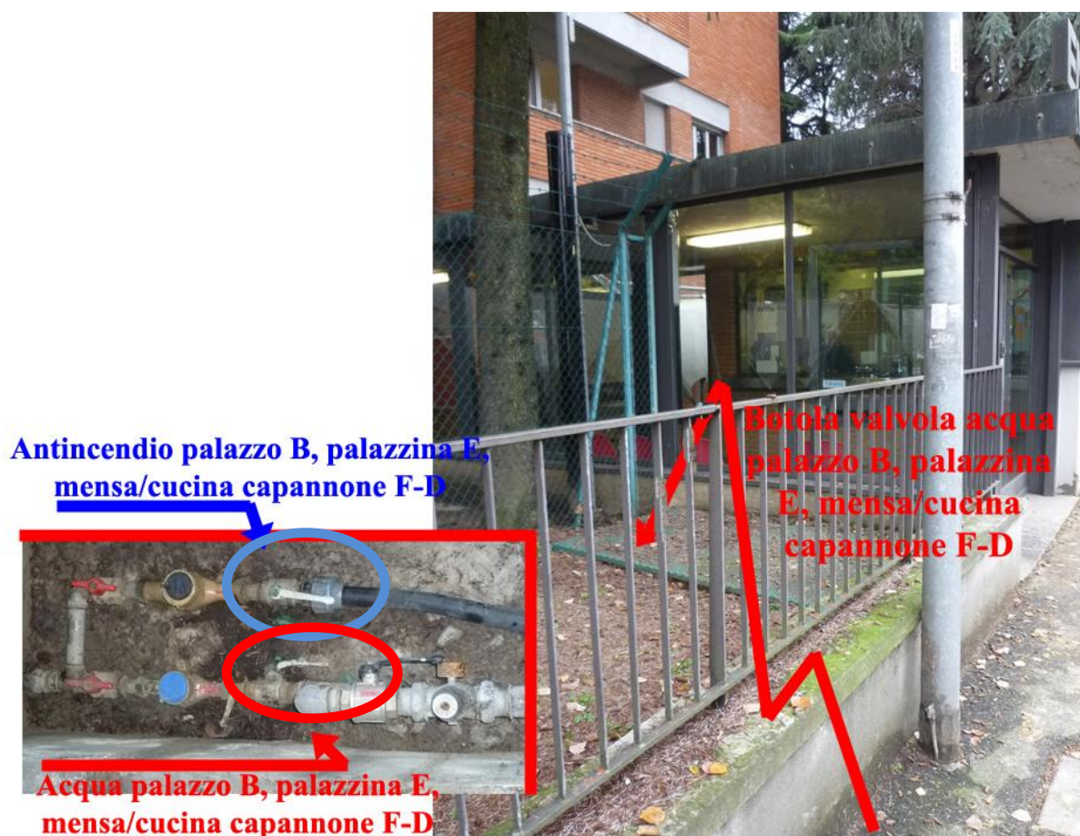
Figura 5.9 –Il vano valvole acqua palazzo B, palazzina E, mensa/cucina capannone F-D e la via più breve per raggiungerlo.
