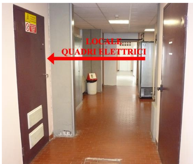
Figura 10.6 – Locale quadri elettrici
