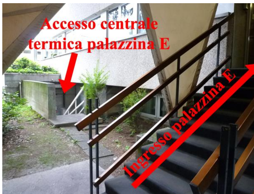
Figura 2.12 – Ubicazione centrale termica palazzina E
