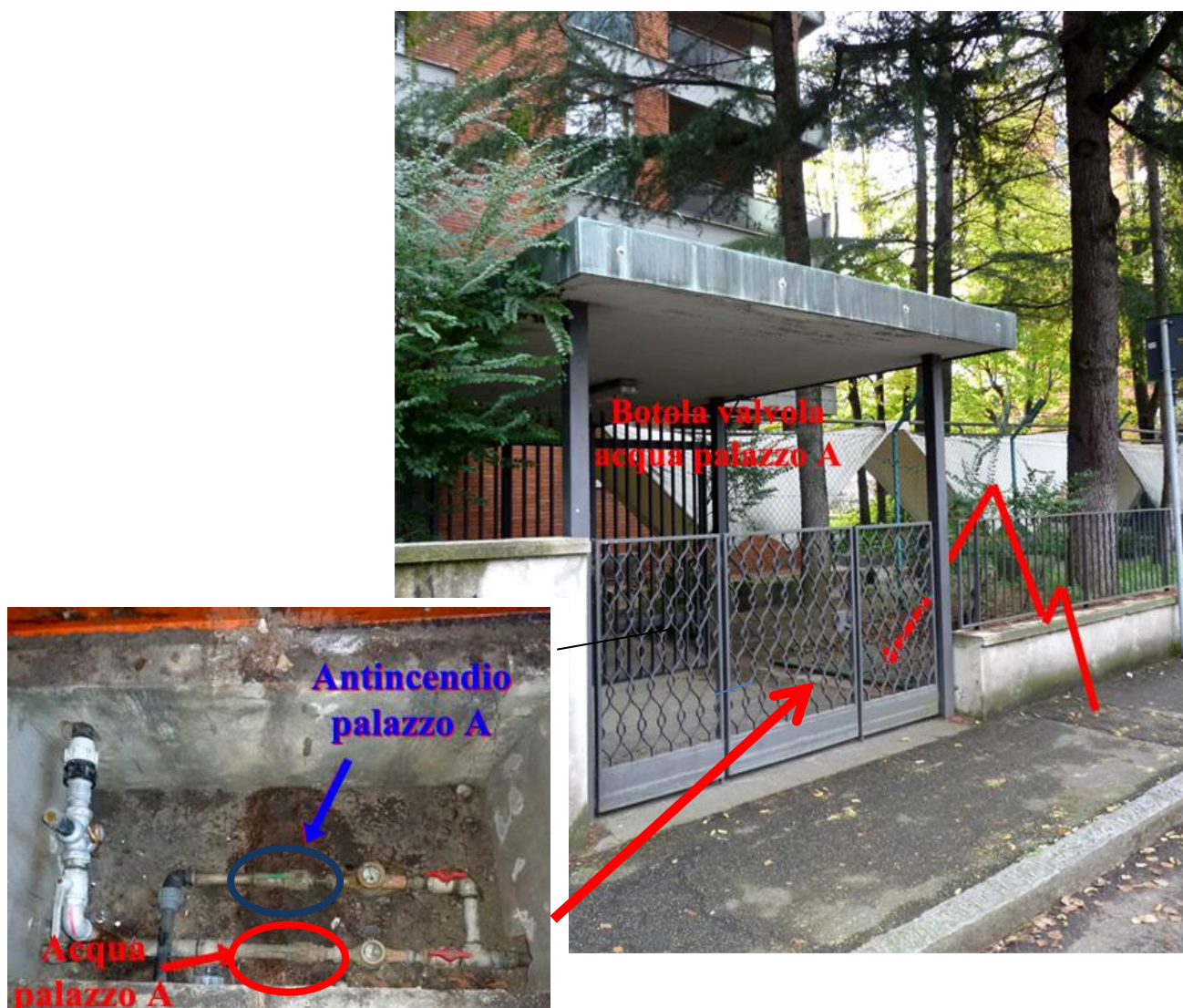
Figura 5.1 –Il vano valvole generali acqua palazzo A e la via più breve per raggiungerlo.
