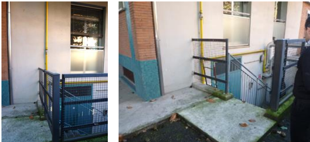
Figure 3.7 e 3.8 – Accesso al locale quadri elettrici generali del Capannone F-D
