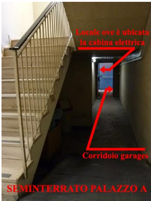
Figura 3.15 – Cabina elettrica, accesso dal seminterrato del palazzo A
