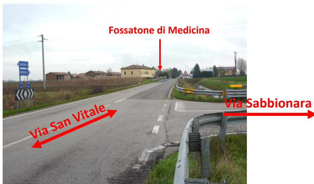
Figura 11.2 – L'incrocio con via Sabbionara
