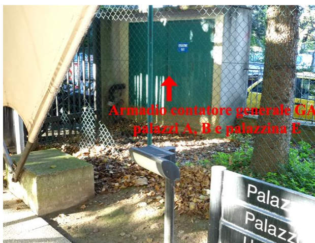
Figura 2.3 – Posizione contatore generale gas palazzi A, B e palazzina E
