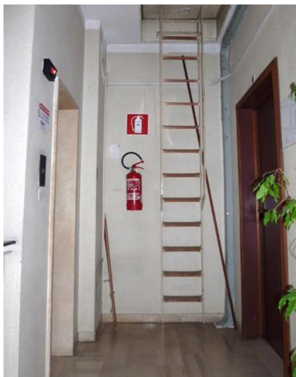
Figura 8.1 – Botola di accesso alla sala macchine ascensori palazzi A e B
