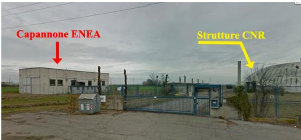
Figura 11.4 – Veduta del sito ENEA di Medicina
