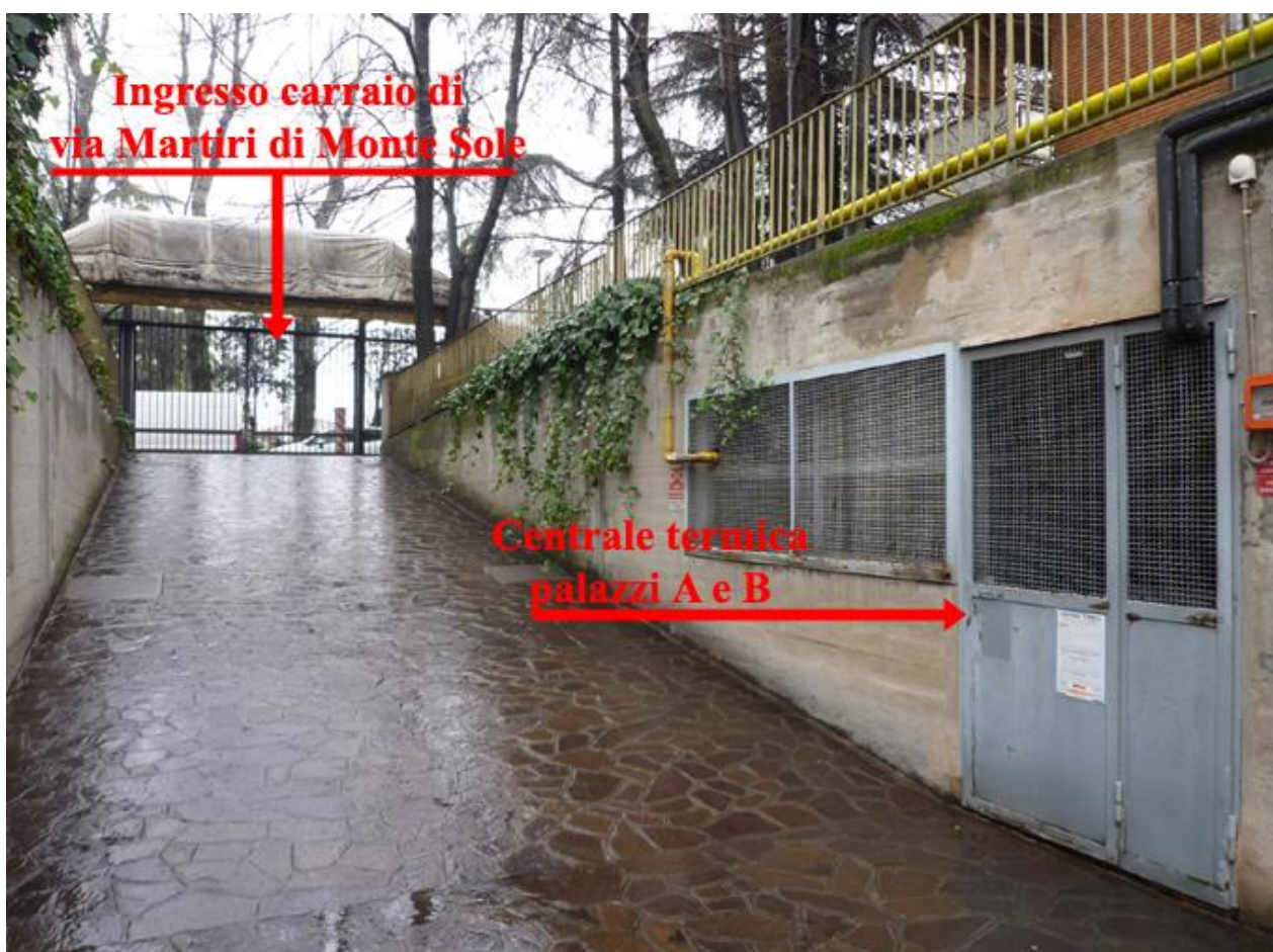
Figura 6.1 – Centrale termica palazzi A e B
