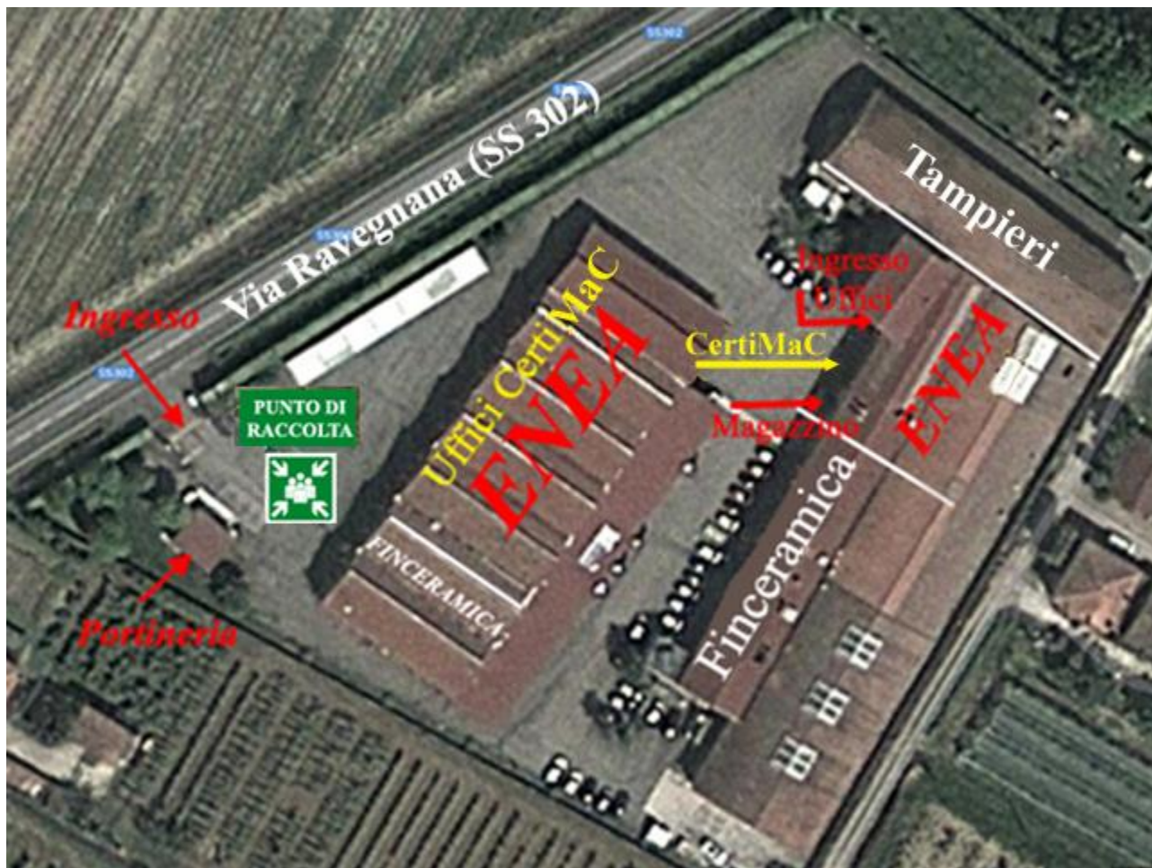
Veduta generale del sito di Faenza, Via Ravennana 186
