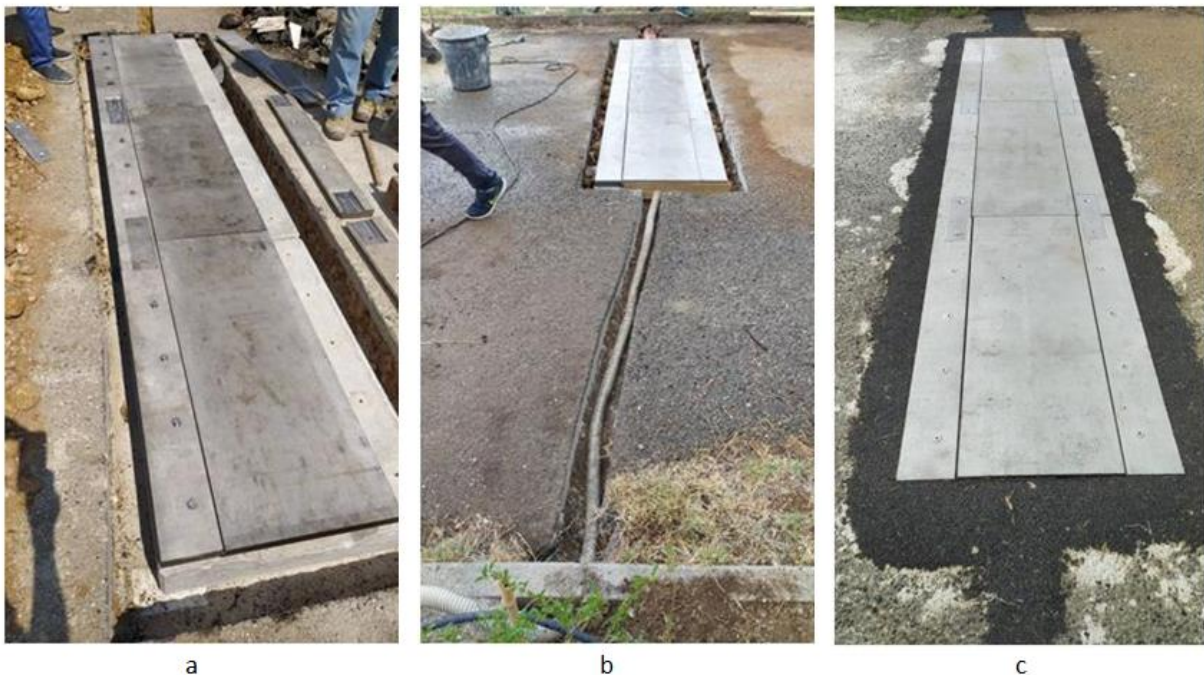
Figura 89. a) posizionamento piastre, b) passaggio cavi collegamento ottico, c) ripristino asfalto
