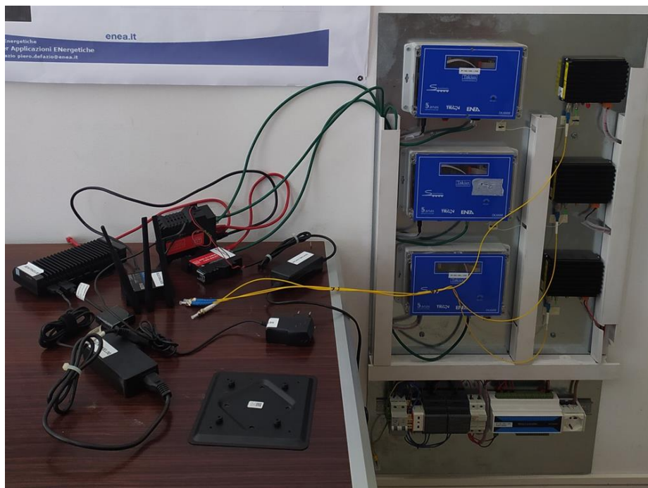
Figura 96. strumentazione di acquisizione e controllo
