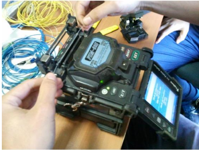
Figura 33. inserimento del termorestringente.
