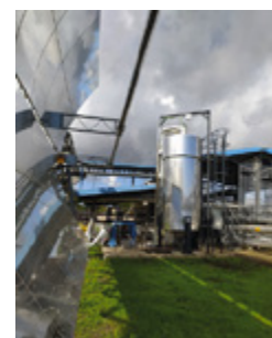
Vista del circuito sperimentale RESLAG
