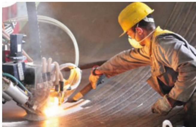
Fabbricazione del rivestimento resistente al piombo liquido
