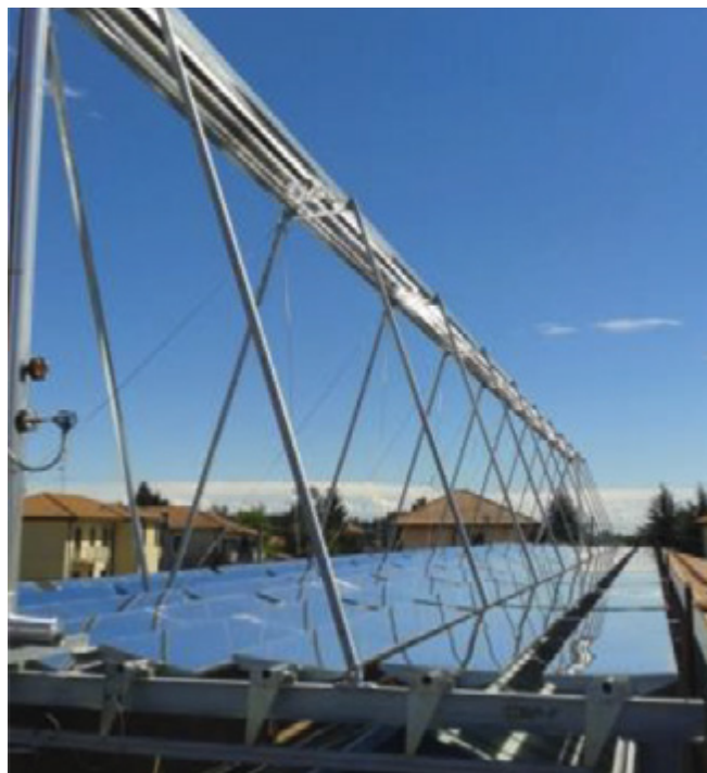
Esempio di test on-site di un collettore a concentrazione
