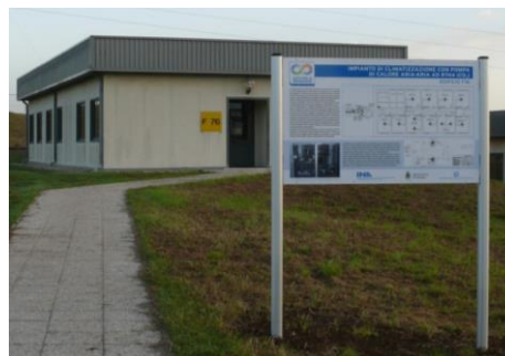
Figura 478. Edificio F76- C.R. ENEA Casaccia
