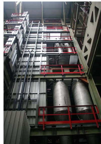
Figura 325. Serbatoi del contenimento SPES-3 installati sulla struttura
