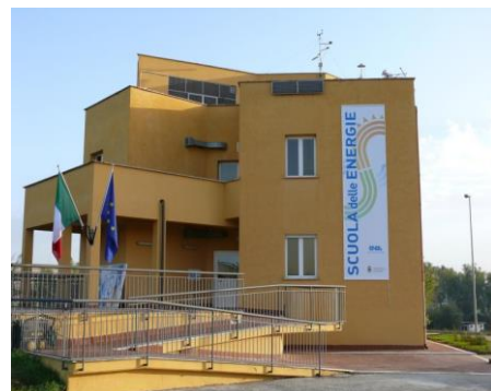
Figura 429. Edificio F92 - C.R. ENEA Casaccia
