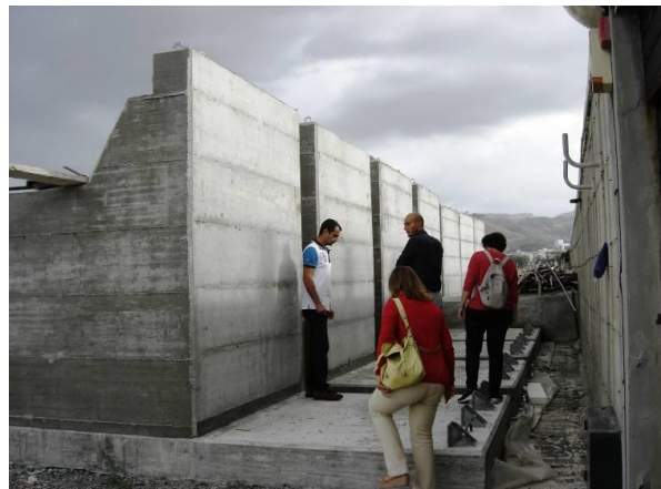
Figura 222. Basamento dell'apparato U-OWC sperimentale in corso di realizzazione presso il Laboratorio marittimo dell'Università di Reggio Calabria
