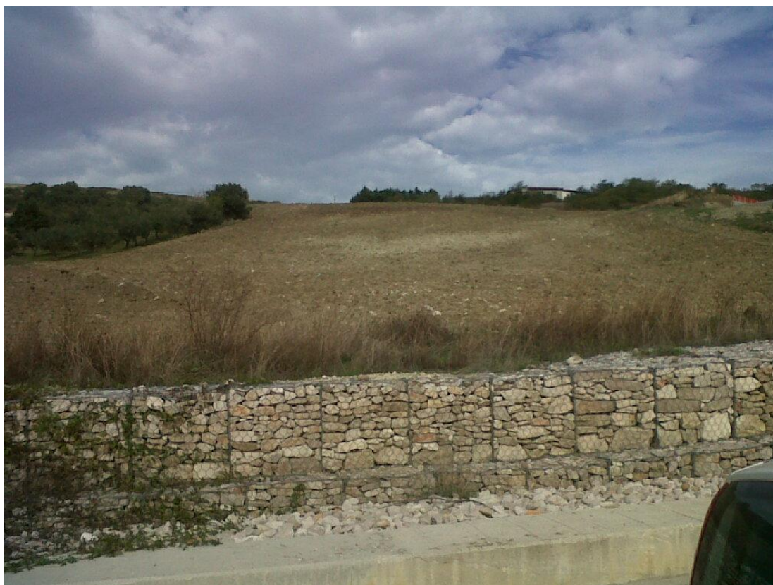
Figura 12 - Gabbionata di contenimento realizzata in prossimità del cimitero.
