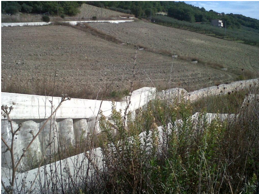
Figura 11 - Sistemazione della rete idrografica superficiale nell'incisione valliva ad est del centro abitato.
