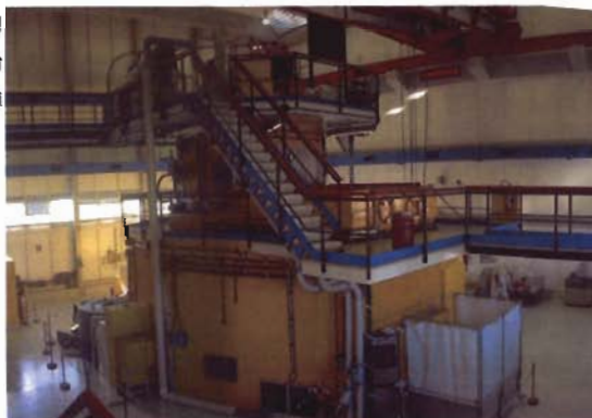
Fig. 4.24 Reattore TRIGA RC-1 del CR Casaccia sala reattore e interno della piscina
