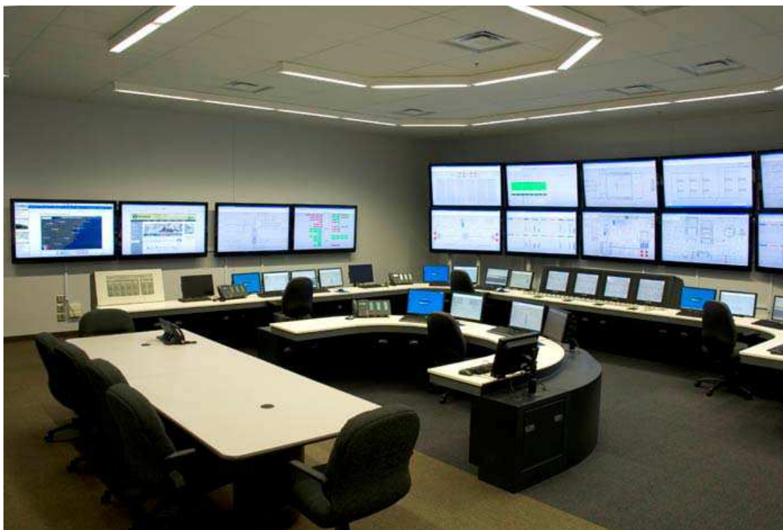
Fig. 2-1 Simulatore Westinghouse di sala controllo dell'impianto AP1000
