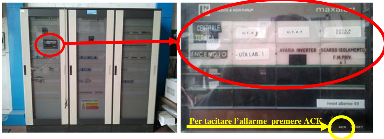
Figura n. 12.4 – Display allarmi zona ampliamento
