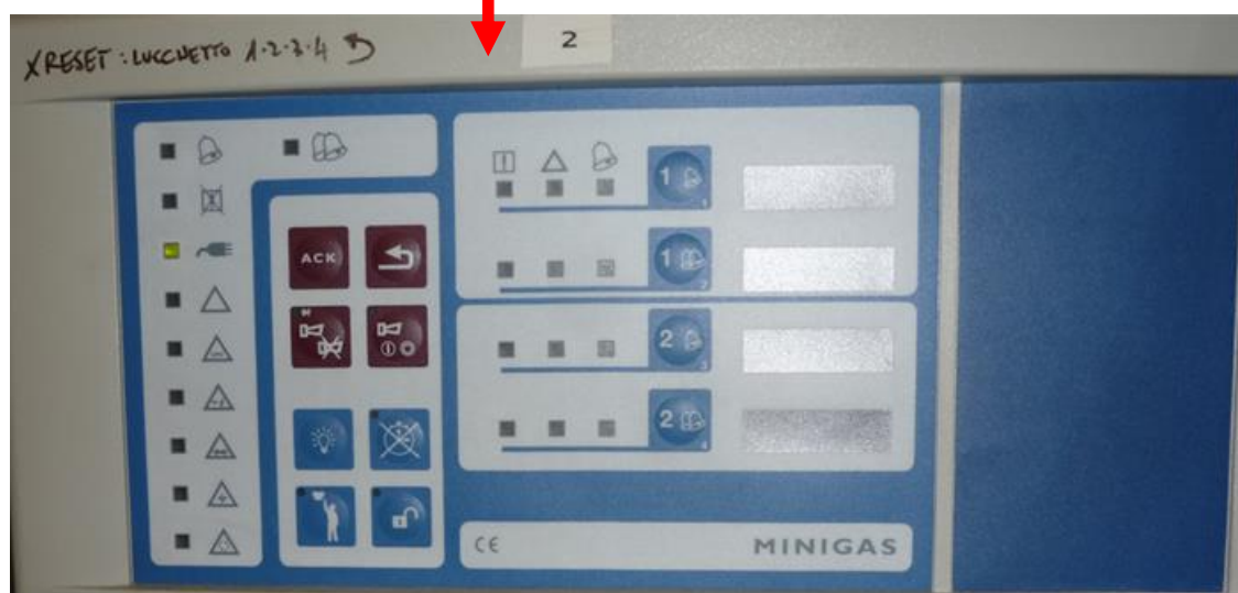
Figura 12.5 – Centrale termica 1 e relativa centralina allarmi
