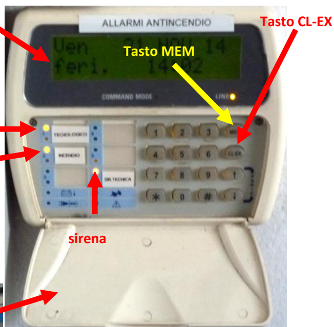
Figura 12.2 – Centralina allarme zona CP1 – CP5
