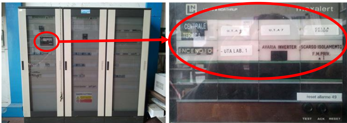
Figura n. 11.7 – Display allarmi zona ampliamento
